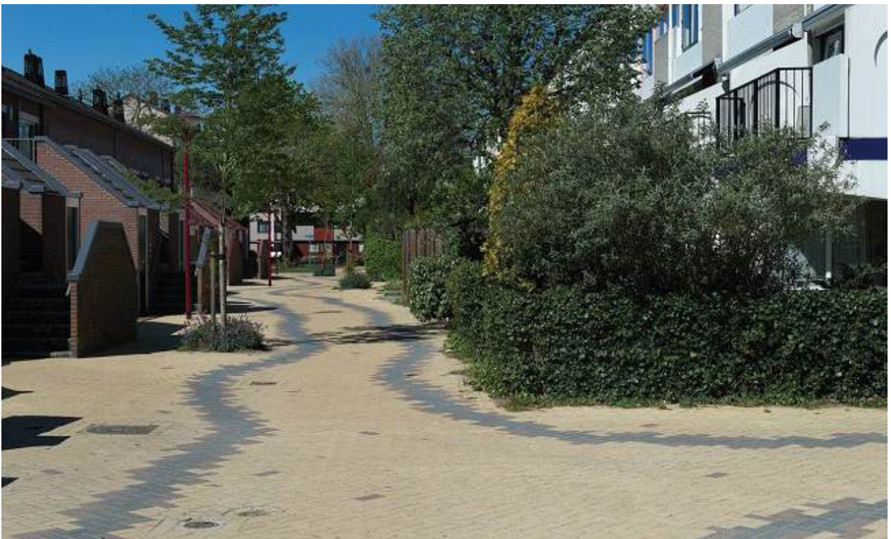
Figuur E6: Karrespoor in de verharding van de Landauerdrift. Overgenomen uit Struyk Verwo Infra (z.d.)
